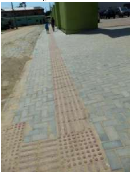
Figura 7 - Calçada na Rua Monte Castelo, Bairro Monte Alegre em frente à nova escola.
