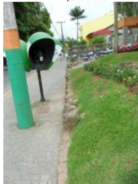
Figura 10 - Bairro Centro - presença de mobiliário urbano mal posicionado.
