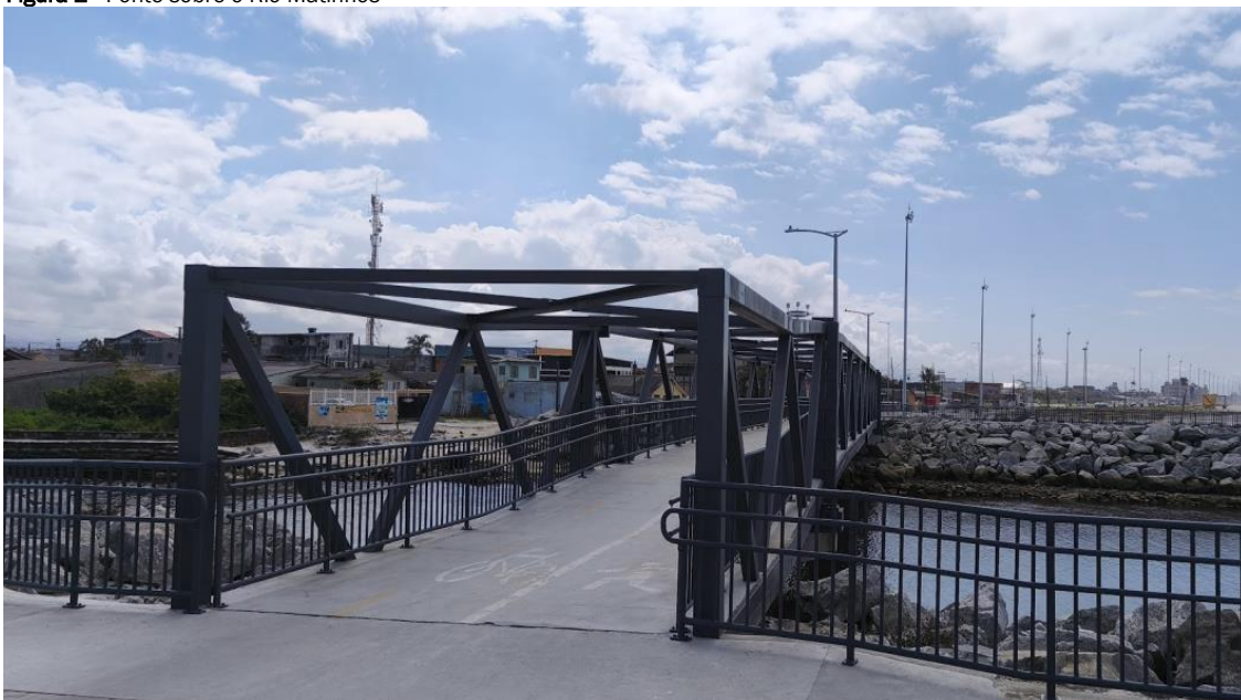
Figura 2 - Ponte sobre o Rio Matinhos
